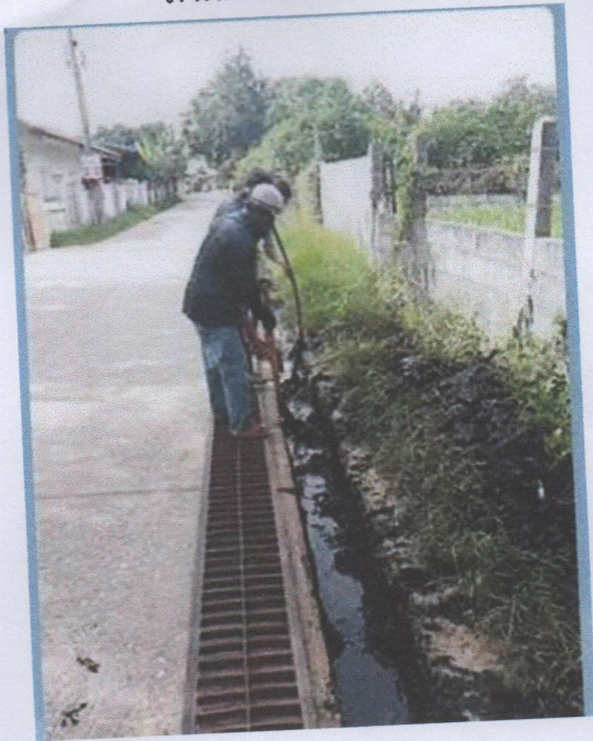
ภาพการดำเนินการจัดการน้ำเสียในหมู่บ้าน หมู่ที่ ๑๑ หน้าโรงเรียนบ้านบึง
